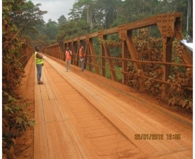
**Pont semi-définitif :** C'est un pont construit conjointement avec du matériel définitif et du matériel non définitif.
