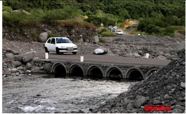
**Pont** : Un pont est une construction qui permet de franchir une dépression ou un obstacle (cours d'eau, voie de communication...) en passant par dessus. Les ponts font partie de la famille des ouvrages d'art.
